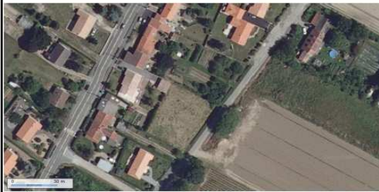
Vue aérienne, source : Géoportail
