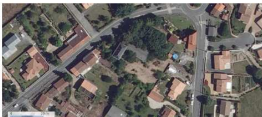
Vue aérienne, source : Géoportail
