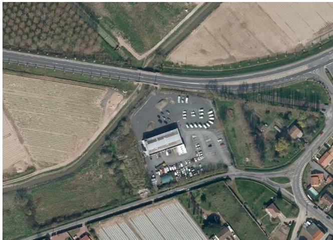
Vue aérienne du site d'activités de la route des Faucardeurs
