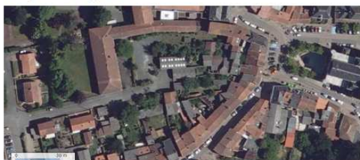
Vue aérienne, source : Géoportail
