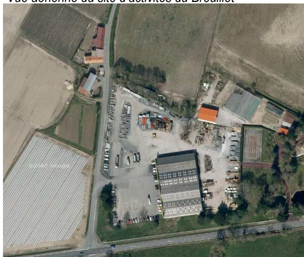
Vue aérienne du site d'activités du Breuillet
