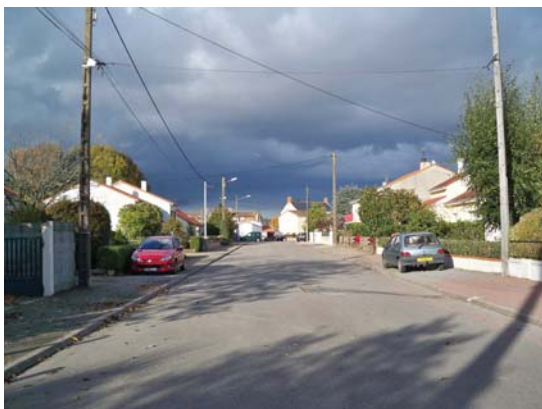
Rue du Petit Cheminet Terminée en impasse pour éviter les circulations de transit Stationnements sur les trottoirs malgré la largeur de la chaussée
