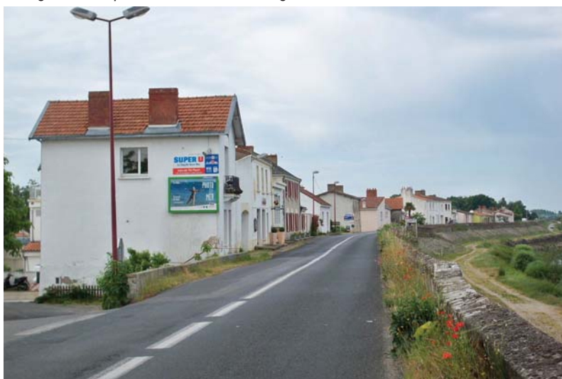
Ligne bâtie épousant le tracé de la digue à la Chebuette
