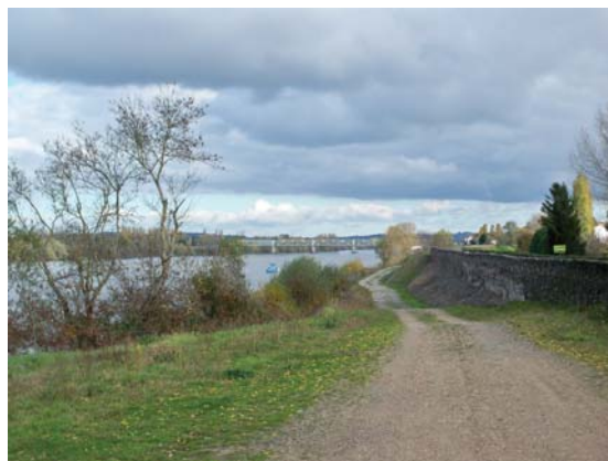
Cale en dessous de la levée.
