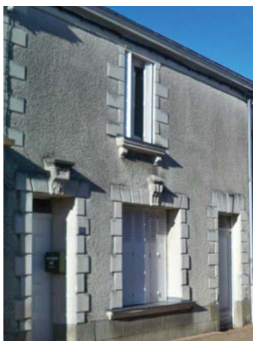
Détails d'architecture, rue de la Vendée
