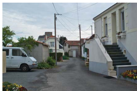
Accès sur les arrières en contrebas de la levée
