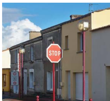
Maintien des corniches et encadrements Utilisation raisonnée des colorations Rue de la Vendée
